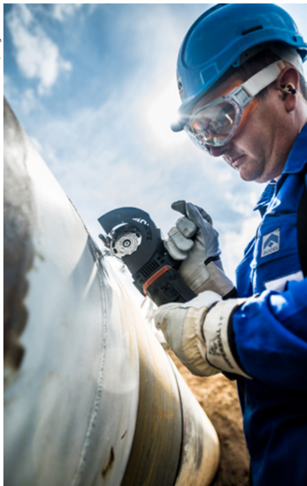
Bild 1: Oberflächenvorbereitungsarbeiten im Pipelinebau
